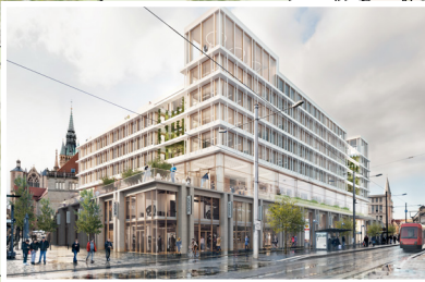
Sanierung des Rathaus-Neubaus Braunschweig 2021
