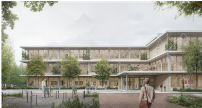
Ersatzneubau Hainberg-Gymnasium in Göttingen 2024
