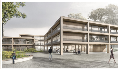
Erweiterung Schulzentrum Duderstadt 2021-2022
