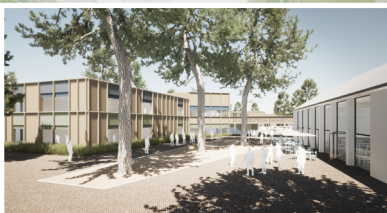
Neubau des Schulzentrums Emmerthal 2022
